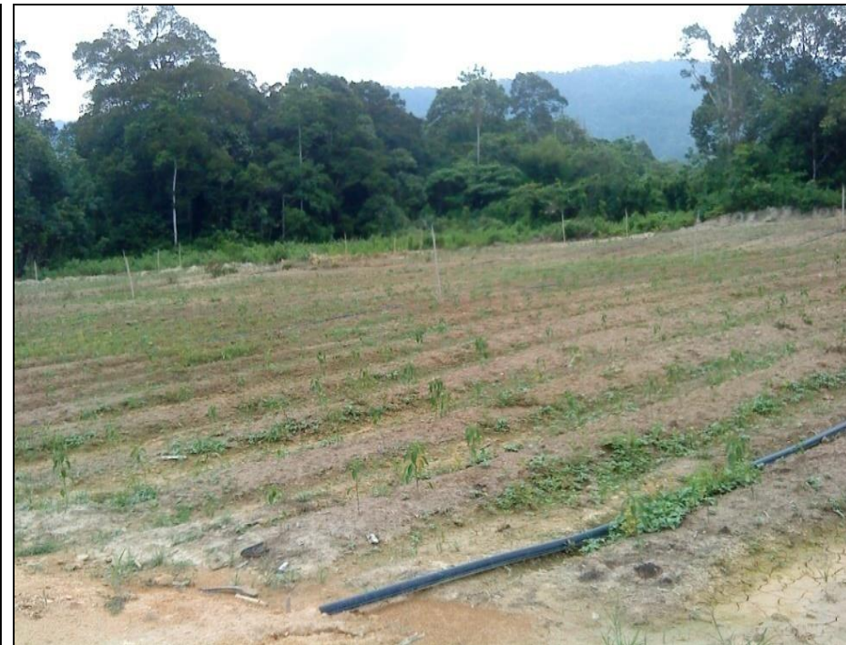
Kerja-kerja penyediaan kawasan telah selesai
