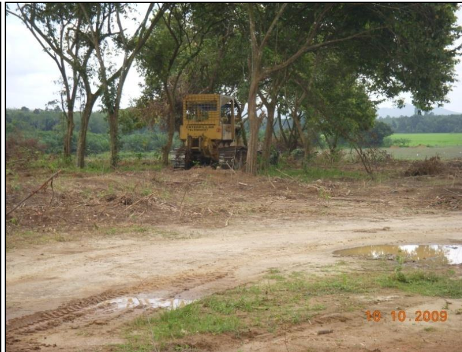
Kerja-kerja penyediaan kawasan sedang dilaksanakan
