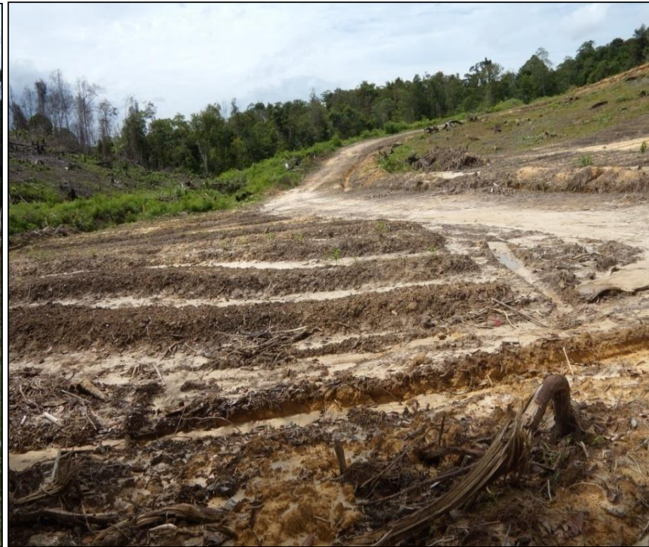
Kerja-kerja penyediaan kawasan telah selesai
