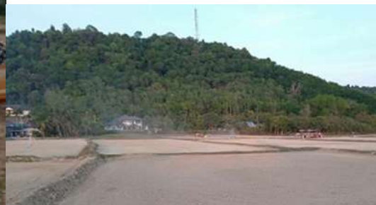
Petak Sawah yang telah selesai diratakan
