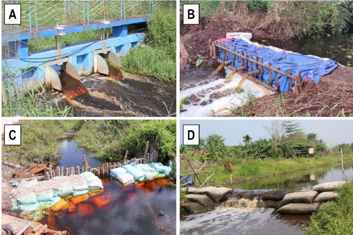
Rajah 4.9: Jenis infrastruktur kawalan saluran air bagi mengelakkan air bertakung di kawasan penanaman ketika musim hujan dan menyekat saluran air bagi penyimpanan semasa musim kering: (A) kunci air, (B-C) sekatan parit menggunakan beg pasir dan (D) sekatan saluran jenis geobag (earth-filled bags).
