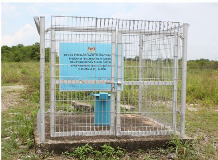
Rajah 4.12: Telaga tiub merupakan struktur bawah tanah yang dibina untuk membolehkan sumber air bawah tanah diekstrak bagi tujuan membasahkan kawasan yang sering terbakar.
