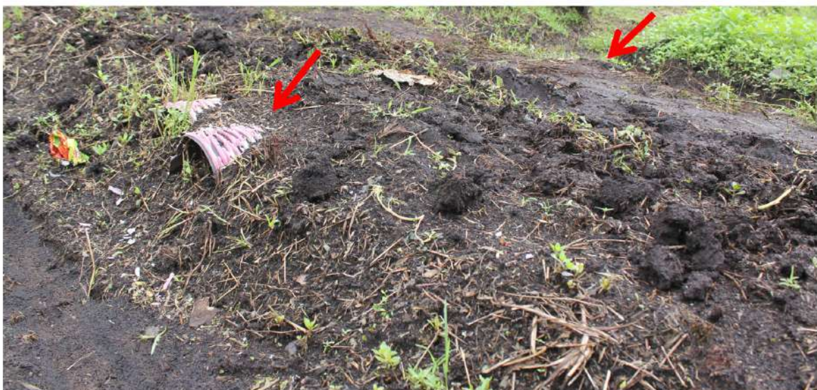
Rajah 4.8: Paip plastik yang ditanam di dalam tanah untuk menghubungkan dua tapak pertanian bagi menyalirkan air yang berlebihan dari satu plot ke plot bersebelahan dan seterusnya ke parit sekunder.
