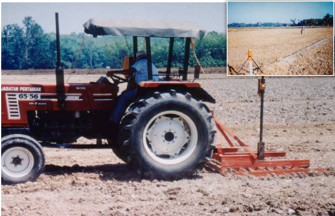
Gambar 10. Kerja-kerja perataan sawah
